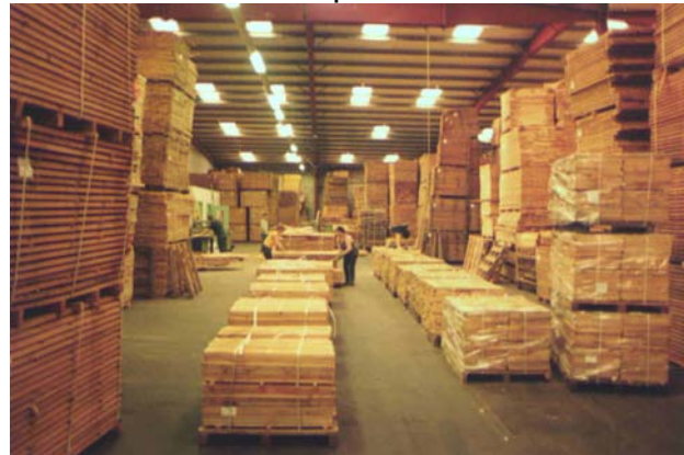
réseau basse température noyé dans la dalle chauffant le hall de stockage des produits finis Chênes de France – Avoine (F)
