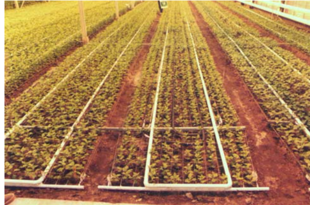
réseau basse température mobile à hauteur de feuilles (chrysanthèmes) Ent. Dufournet – Avoine (F)
