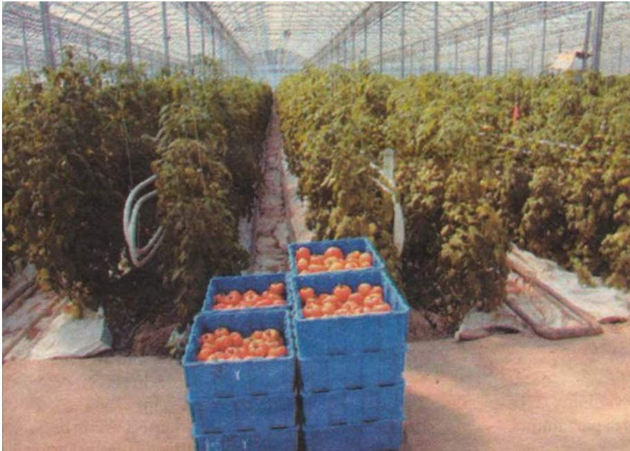
Le complexe de serres Jardin Nature à New Richmond (tomates biologiques) avec réseaux basse température aériens (tubes blancs au milieu de la zone foliaire) et réseaux basse température enterrés.
